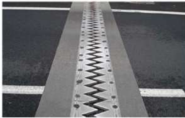
Figure : illustration du joint de type CIPEC Wd110
