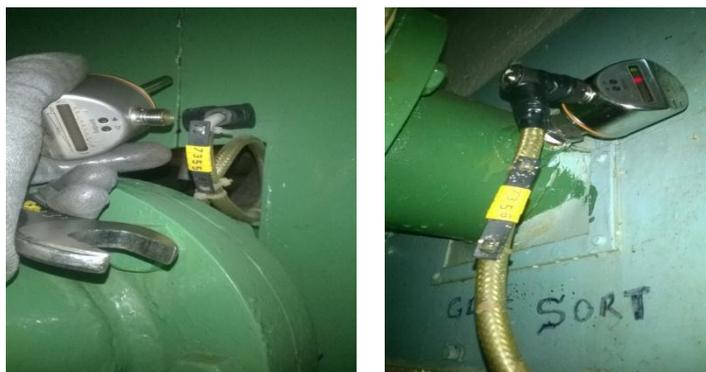
Figure 25: Pose de capteur de circulateur d'eau à TAABO
