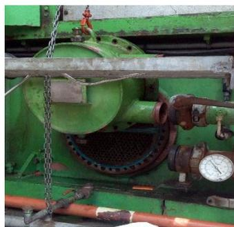
Figure 12: Pose d'échangeur
