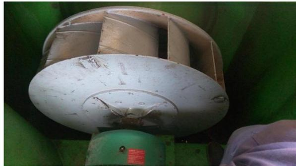
Figure 14: Moteur aéro-réfrigérants
