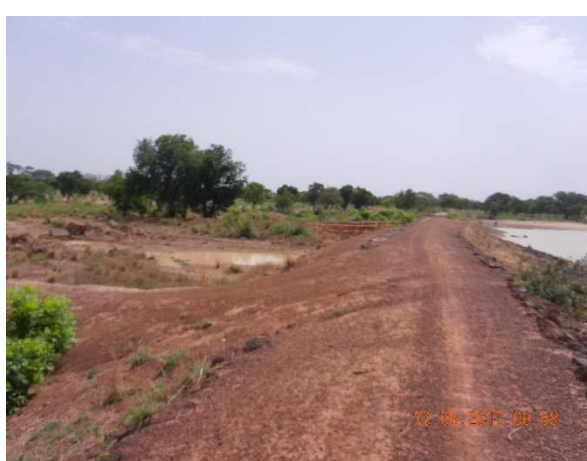
Figure 4: Talus aval de la digue du barrage
