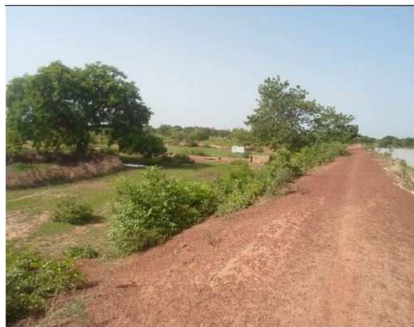
Figure 3: Crête de la digue du barrage
