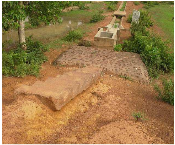
Figure 10: Accès à la prise d'eau
