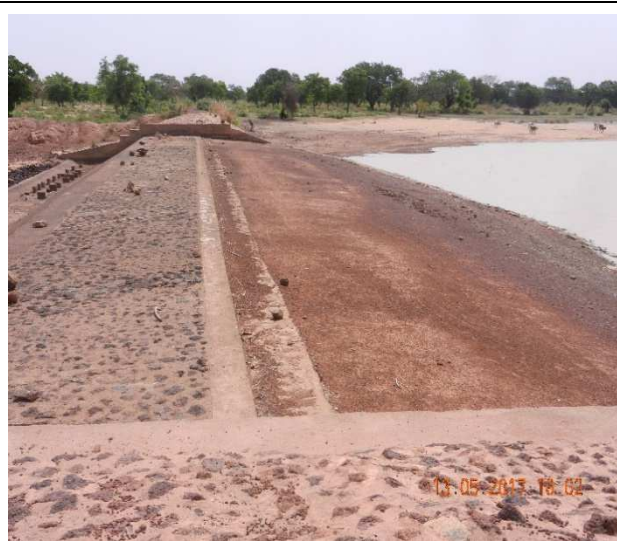
Figure 5: Aperçu du déversoir du barrage
