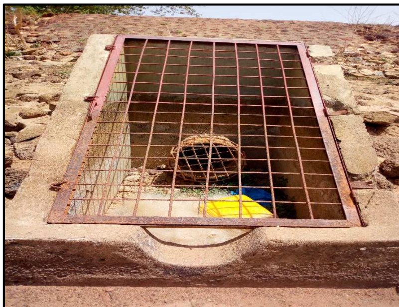
Figure 18: Aperçu de la prise en amont
