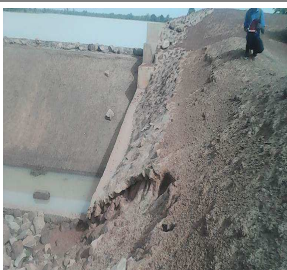
Figure 6: Aperçu du mur bajoyer
