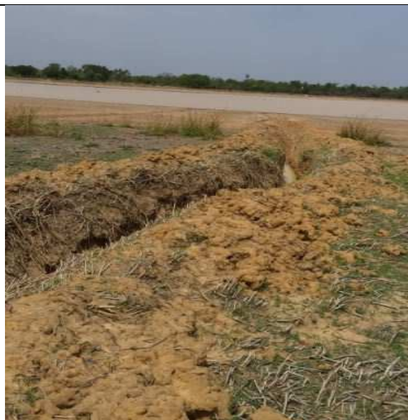
Figure 8: Accès à l'eau du barrage par la cuvette
