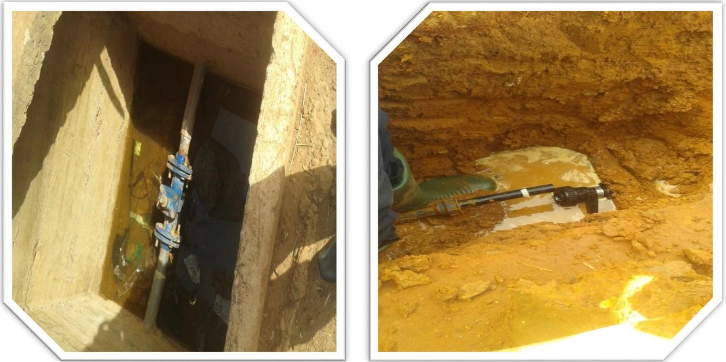
Figure 11 : Fuite dans un regard(à gauche) et Réparation de fuite sur branchements(à droite)
