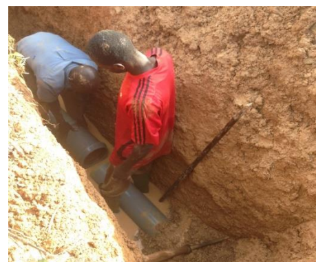
Figure 14: Mise en place d'un manchon
