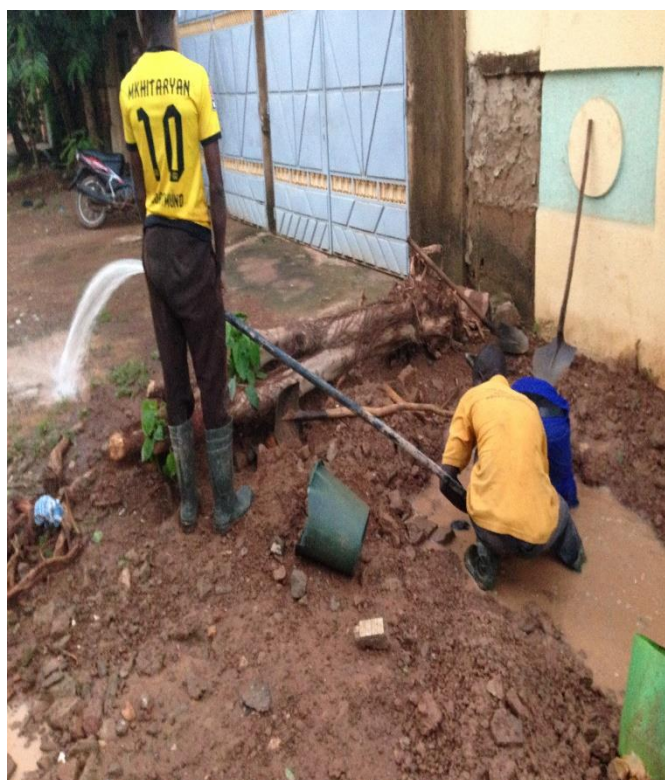
Réparation de fuite sur branchement
