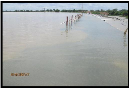
Figure 5: Dégradation de la crête
