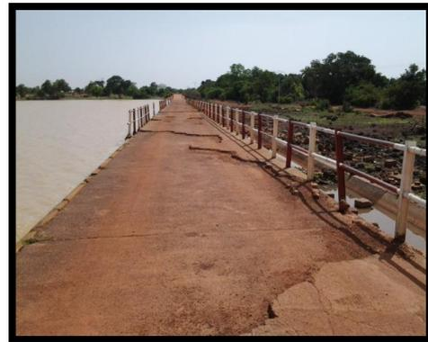
Figure 4: Départ du béton sur le déversoir
