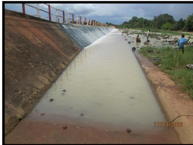
Figure 7: Bassin de dissipation
