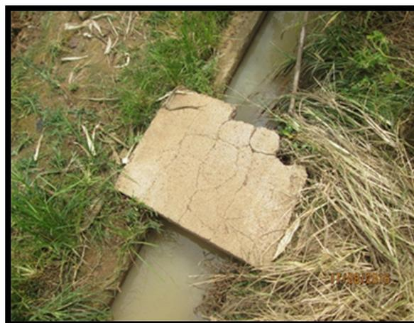
Figure 11 : Canal inondé avec une dalle en mauvais état
