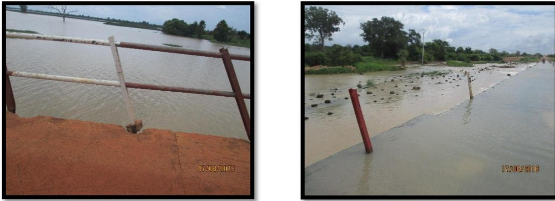
Figure 6:Garde de corps en mauvais état
