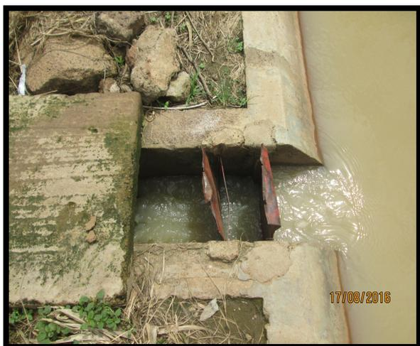
Figure 10: Mauvais état de fonctionnement des vannes
