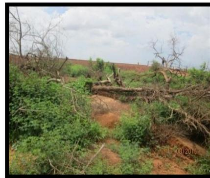
Figure 2: Nids de poule sur la digue du barrage
