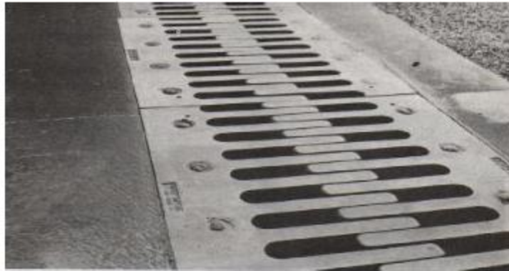
FIGURE 8 : Joint de chaussée de type w
