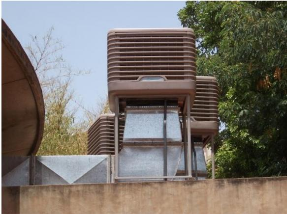
*Figure 6: rafraîchisseur adiabatique installé en toiture*
