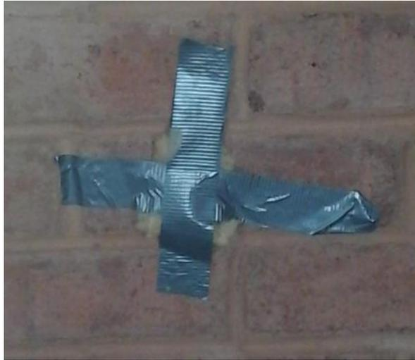
Figure 17 : Mur du bâtiment pilote avec une thermopuce mesurant sa température
