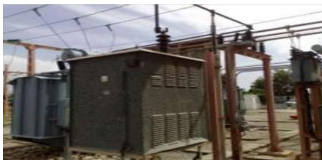
Figure 37 : Une résistance de mise à la terre (RMALTs) Figure 38 : TC neutre
