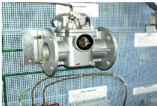
Figure 31 : Relais buchholz-transformateur
