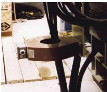
Figure 24: Placement d'un transformateur de type tore
