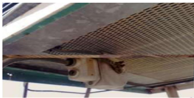
Figure 37 : Une résistance de mise à la terre (RMALTs) Figure 38 : TC neutre
