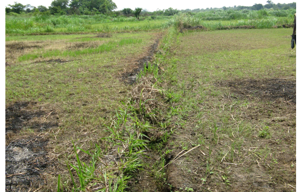
Photo 5 : canal mal entretenu et obstrué
