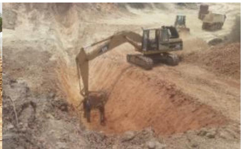
Photo 10 : Ouverture de tranchée d'ancrage du micro barrage de Sam
