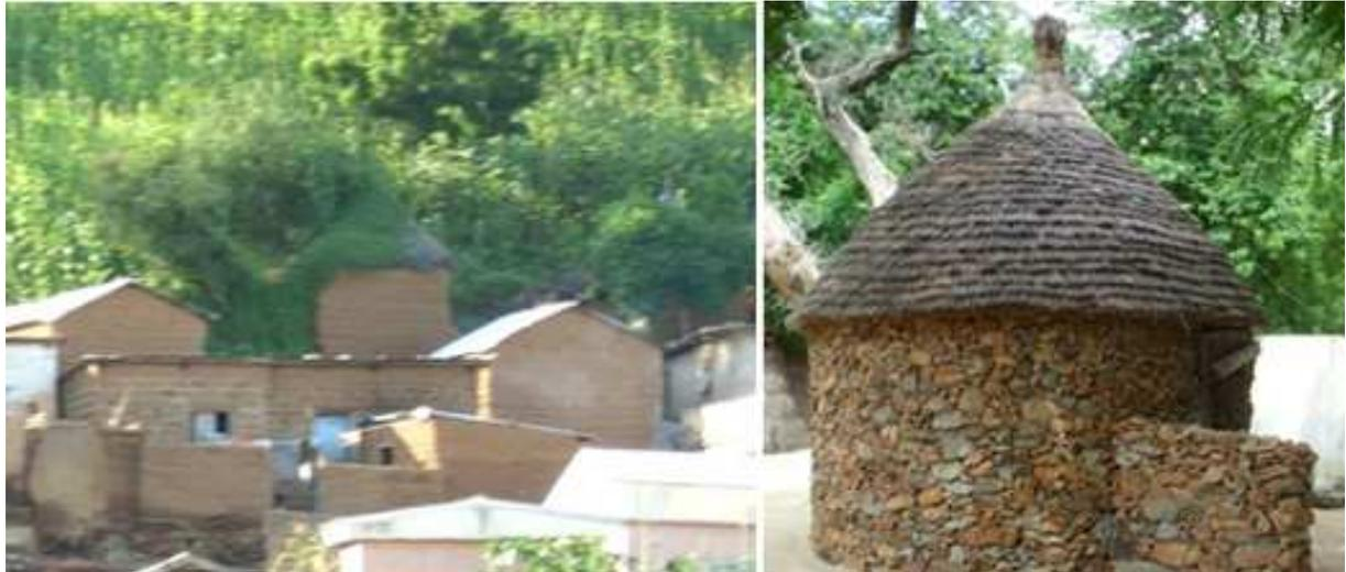
Figure 8 : Habitations en briques de terre comprimées et en pierres
