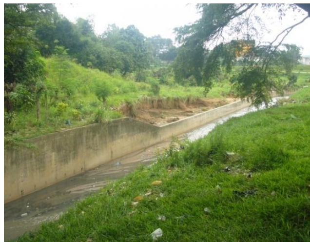
Photo 6 : Canal C 1 au site du Lycée Technique
