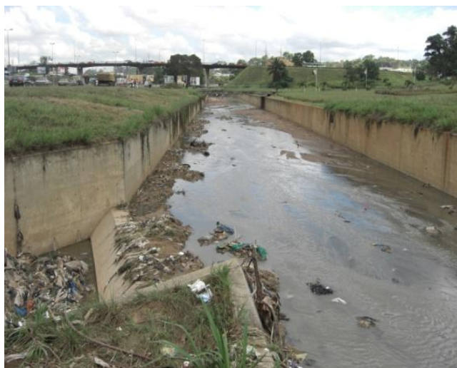
Photo 5 : Point de ramification du canal principal en canaux C 1 et C 2
