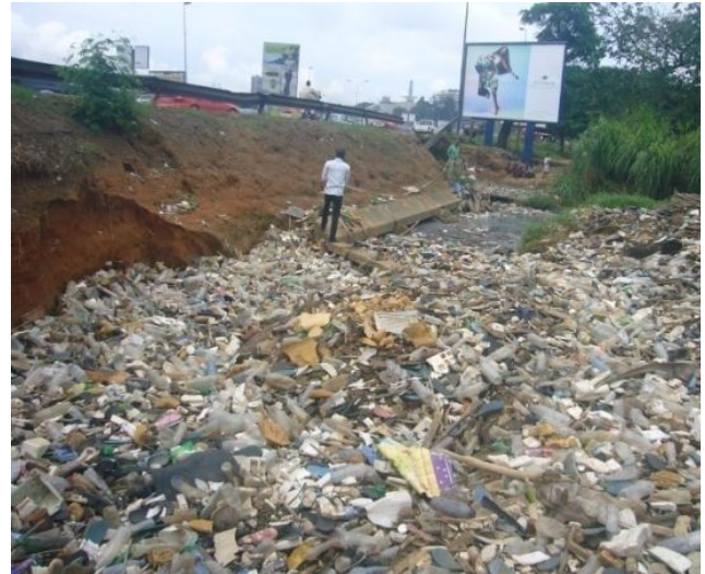
Photo 10 : Dalot en aval du canal C 2
