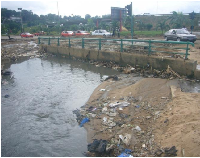
Photo 1 : Carrefour de l'Indenié : Dalots sur C 2 en amont des échangeurs
