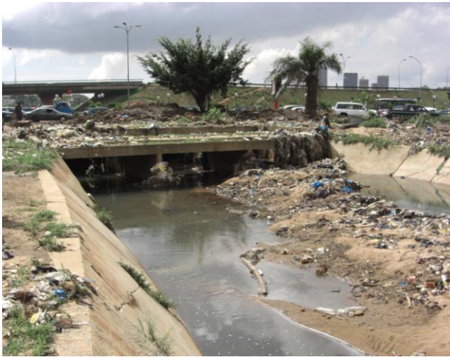
Photo 9 : Dalot en aval du canal C 1
