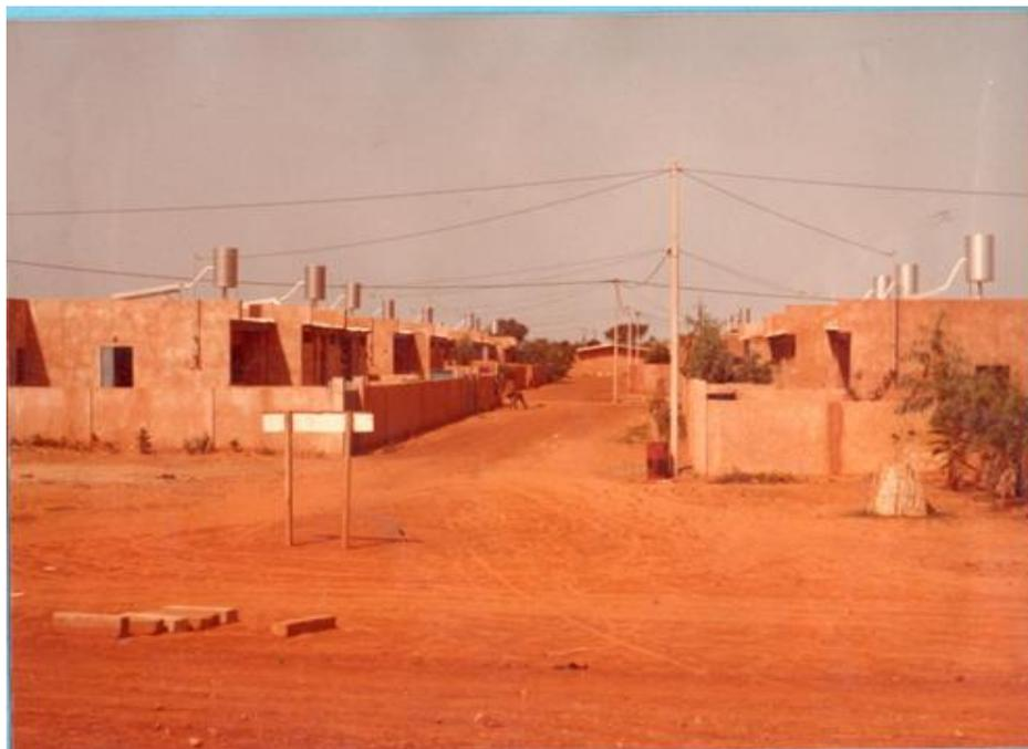
Figure 37 : Chauffe-eau solaire du CNES installés dans une cité de Niamey
