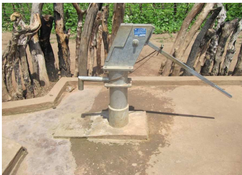
Figure 3 : Pompe de type INDIA MARK II
