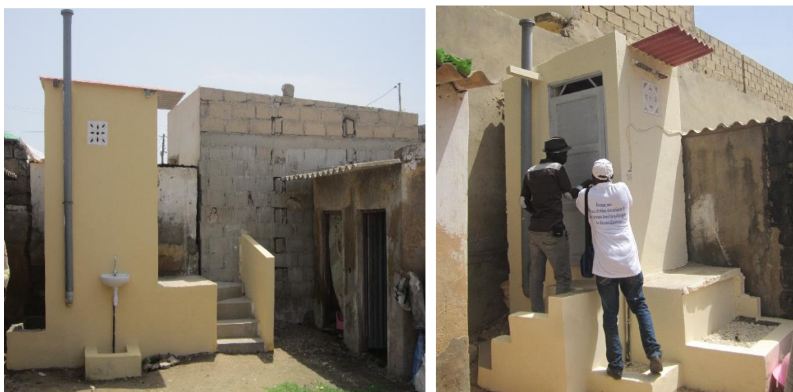
Figure 19: Toilettes Biofilcom réfectionnées, réhabilitées et équipées; Suivi (service après-vente) de la toilette (image à droite) ;
