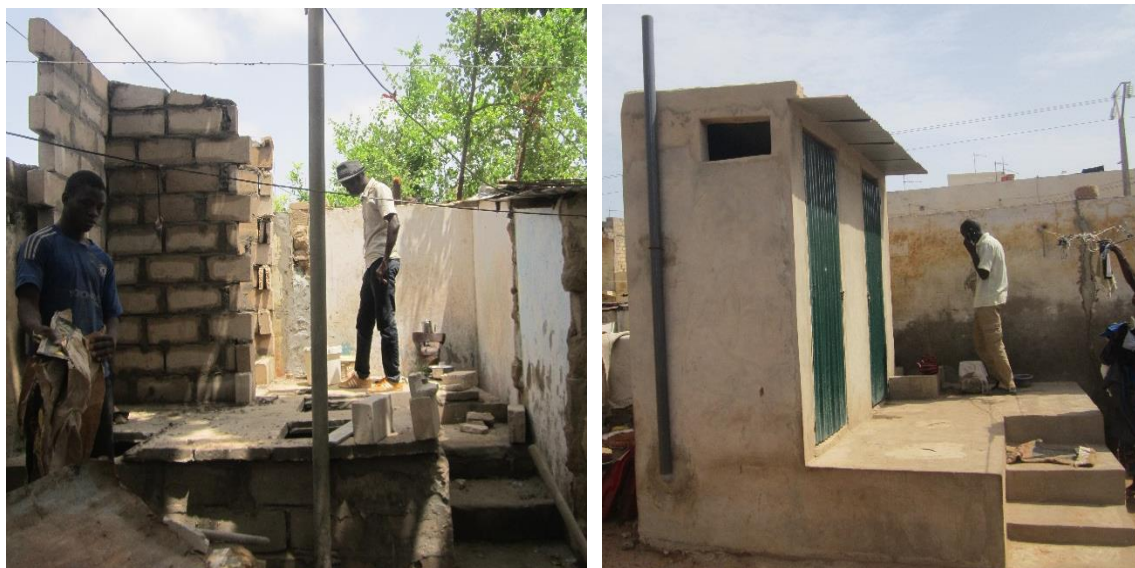
Figure 18: Contrôle - suivi de la toilette Biofilter en construction
