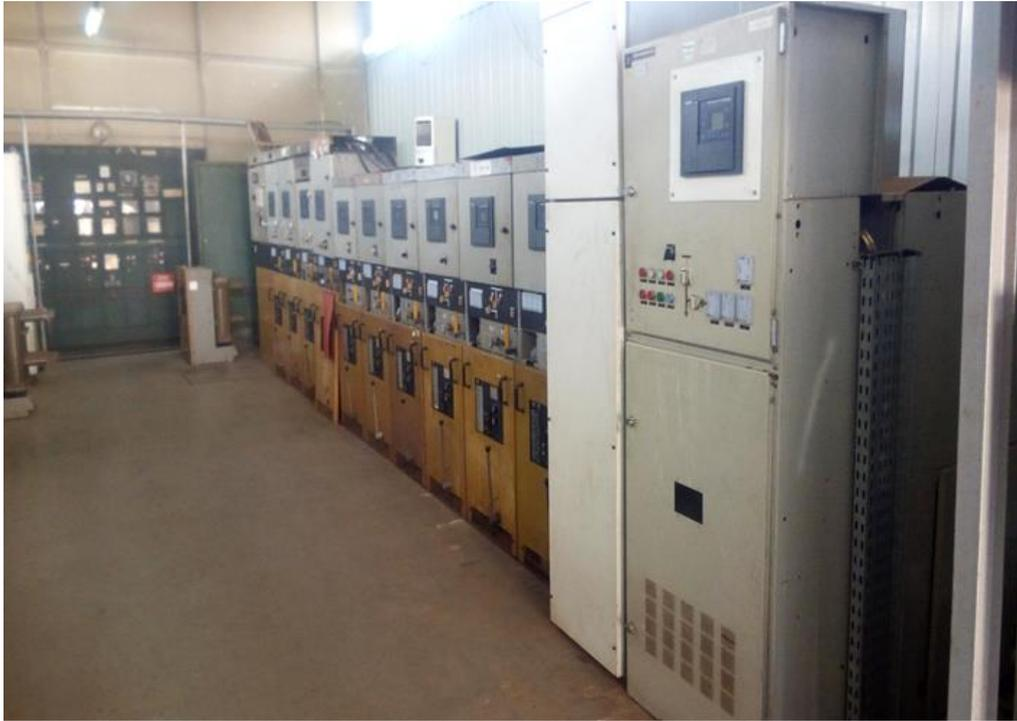
Figure 3: rame de cellules n°2 du poste 90/15/30kV de BRGM
