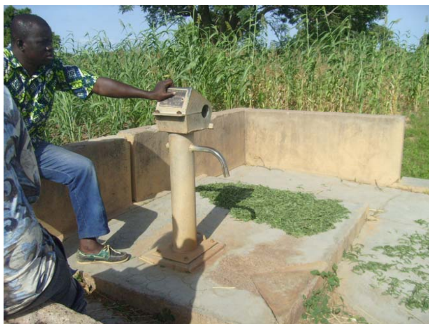
Figure 4 : Forage sans bras dans le village Diafouanou de la commune de Tansarga
