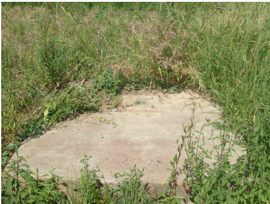
Figure 3 : Forage non équipé de PMH du village de Palboa dans la commune de tambaga
