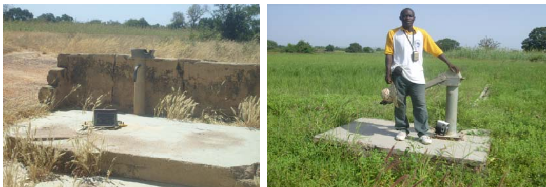
Figure 6 : Forages sans muret ou avec muret dégradé des communes de Tambaga et de bottou
