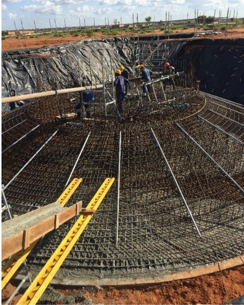
*Photo 3 : Ferrailage de la fondation*
