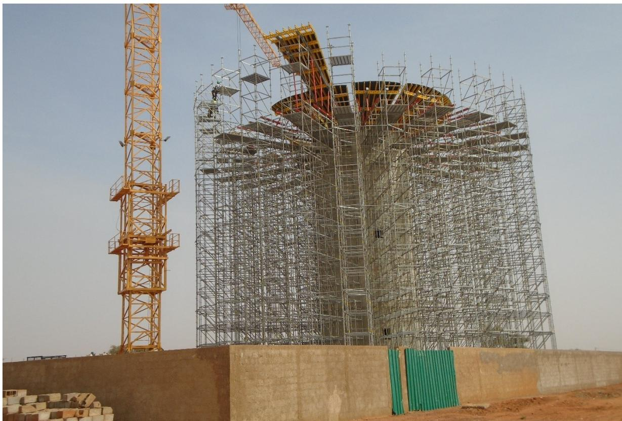
*Photo 1: Disposition des pièces d'échafaudage pour accès au coffrage de la cuve.*
