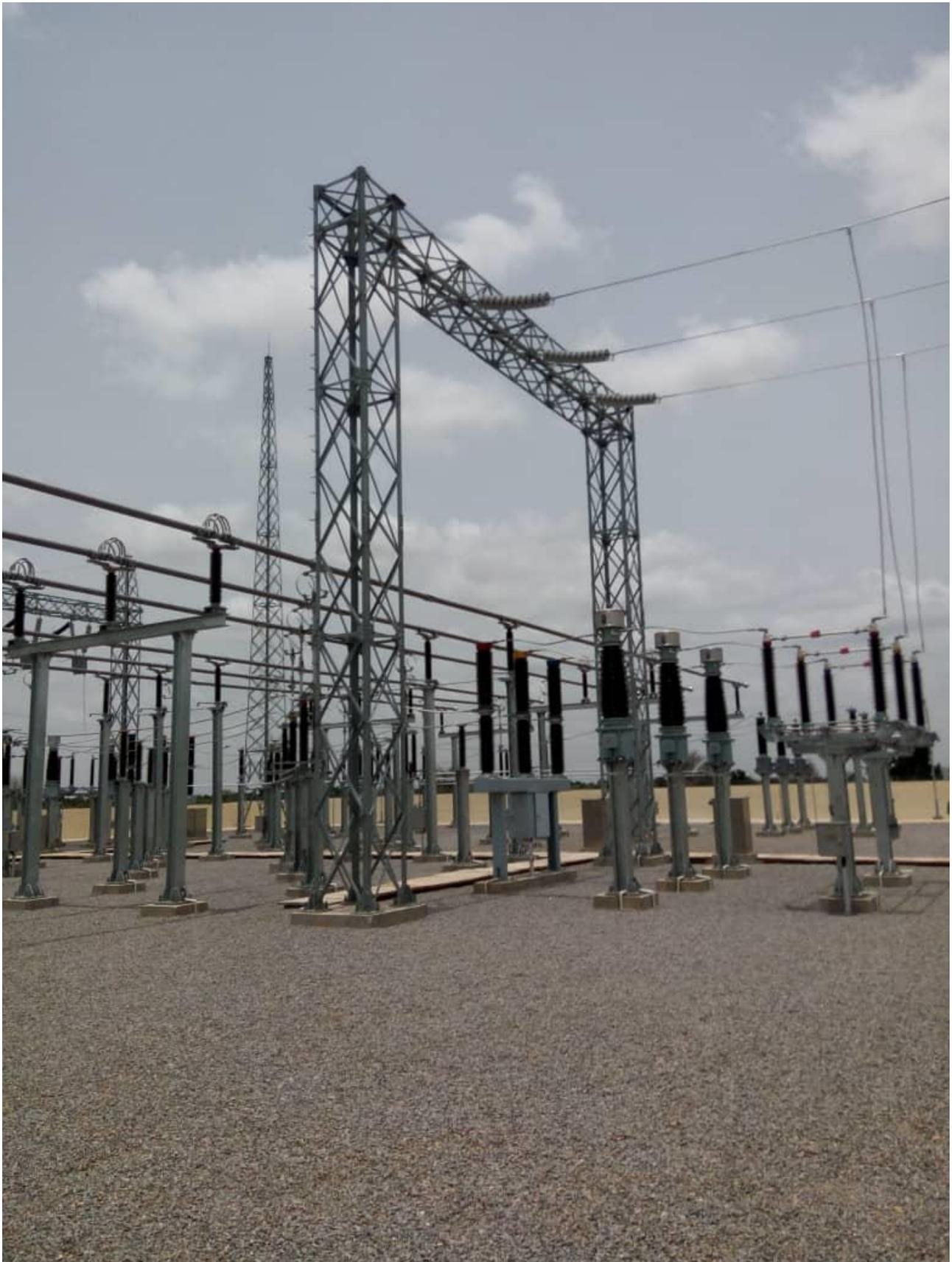
Figure 2: Image illustrative de la travée ligne du poste Maradi 3 (arrivée 132 kV)
