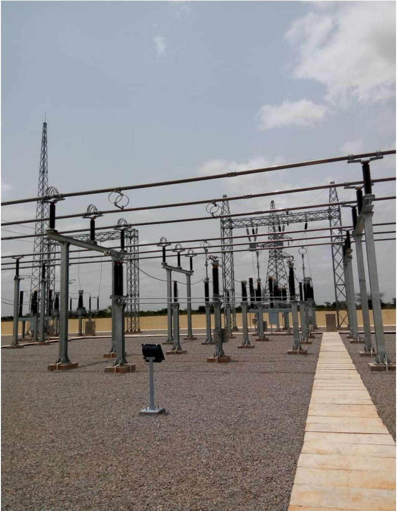
**Figure 3: Image illustrative des deux jeux de barres 132 kV couplables**
