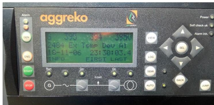
**Figure 3: Alarme Exhaust temperature deviation sur l'écran du GEMPAC**
