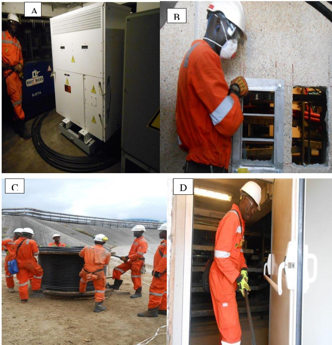
Figure 20 : A : Pose transfo PB510 dans le local, B : Création MCT, C/D : Tirages câbles dans la sous-station.
