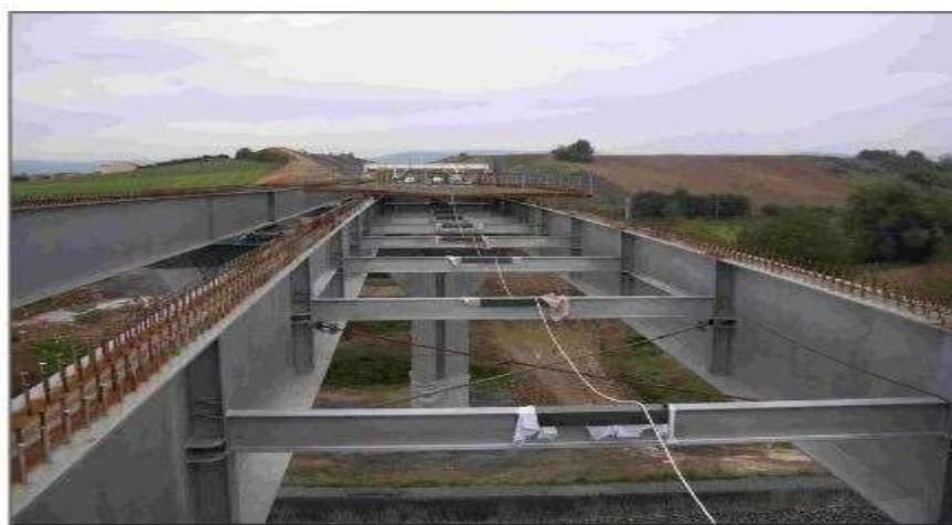
Image 1: Charpente métallique d'un pont mixte
