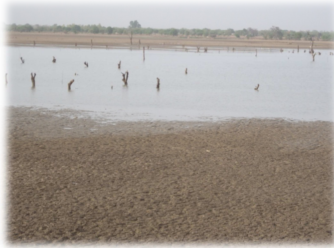
Figure 2: Etat actuel du barrage
