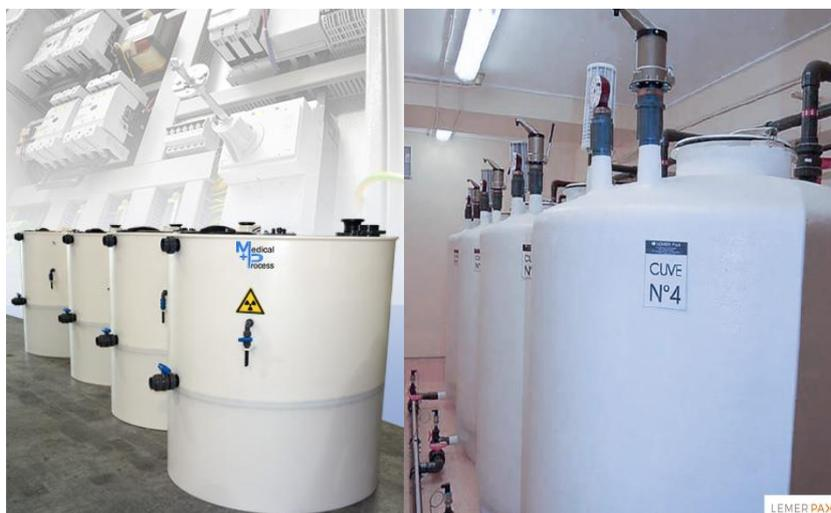
Figure 5: Cuves de décroissance des effluents radioactifs
