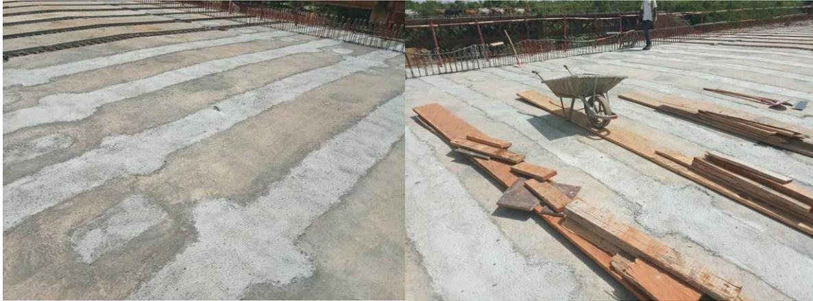
Vue des dalles bétonnées 24h après bétonnage des clavets
