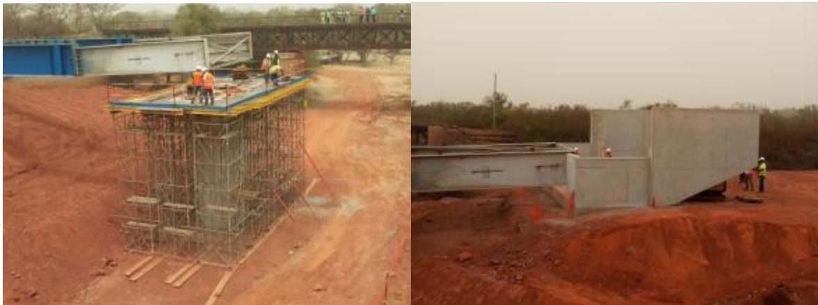
**A gauche, l'avant bec de la charpente atteint la pile P2 ; A droite, l'avant bec arrive en C0**
