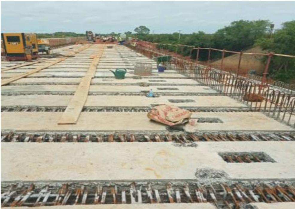
Vue des dalles préfabriquées en place avant début du bétonnage
