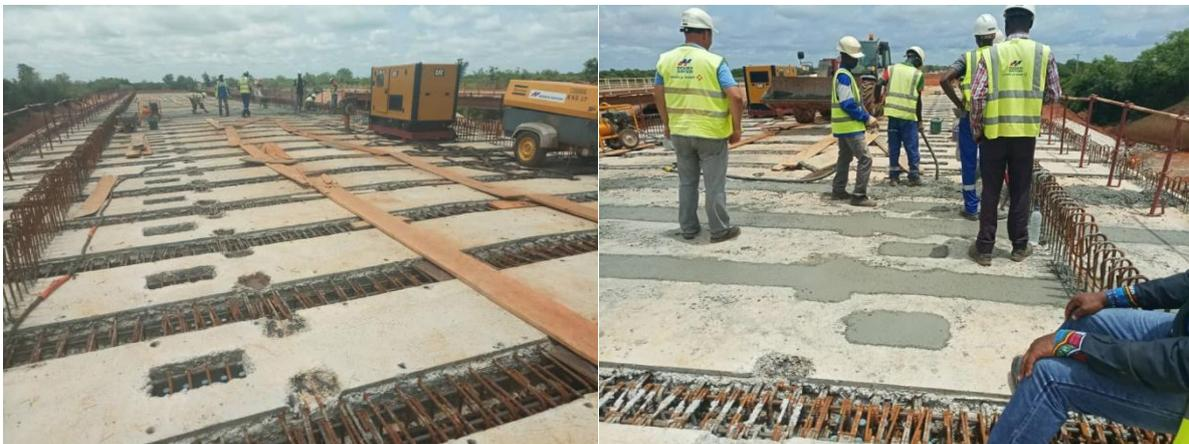
Bétonnage des clavets et vibration du béton
