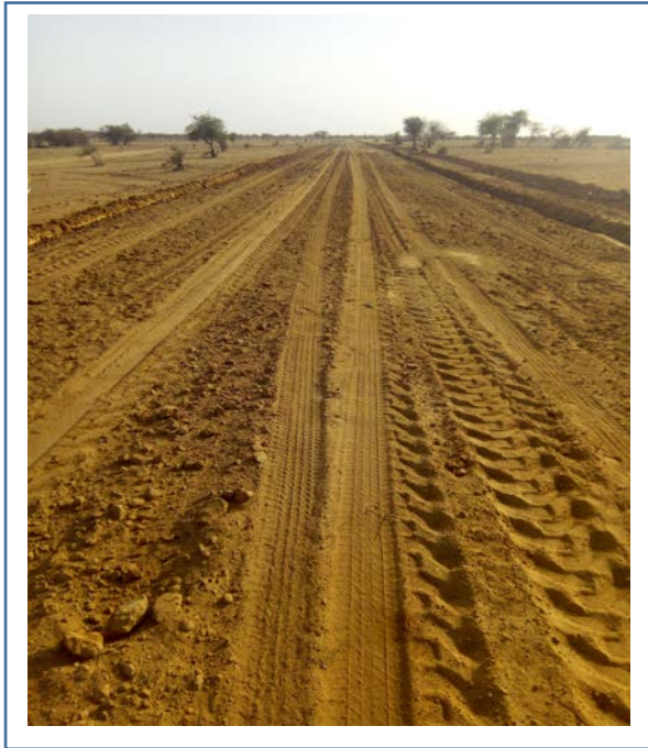
Travaux de Chaussée (piste)
