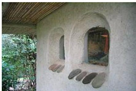
*Figure 1-5: Mur en bauge*
