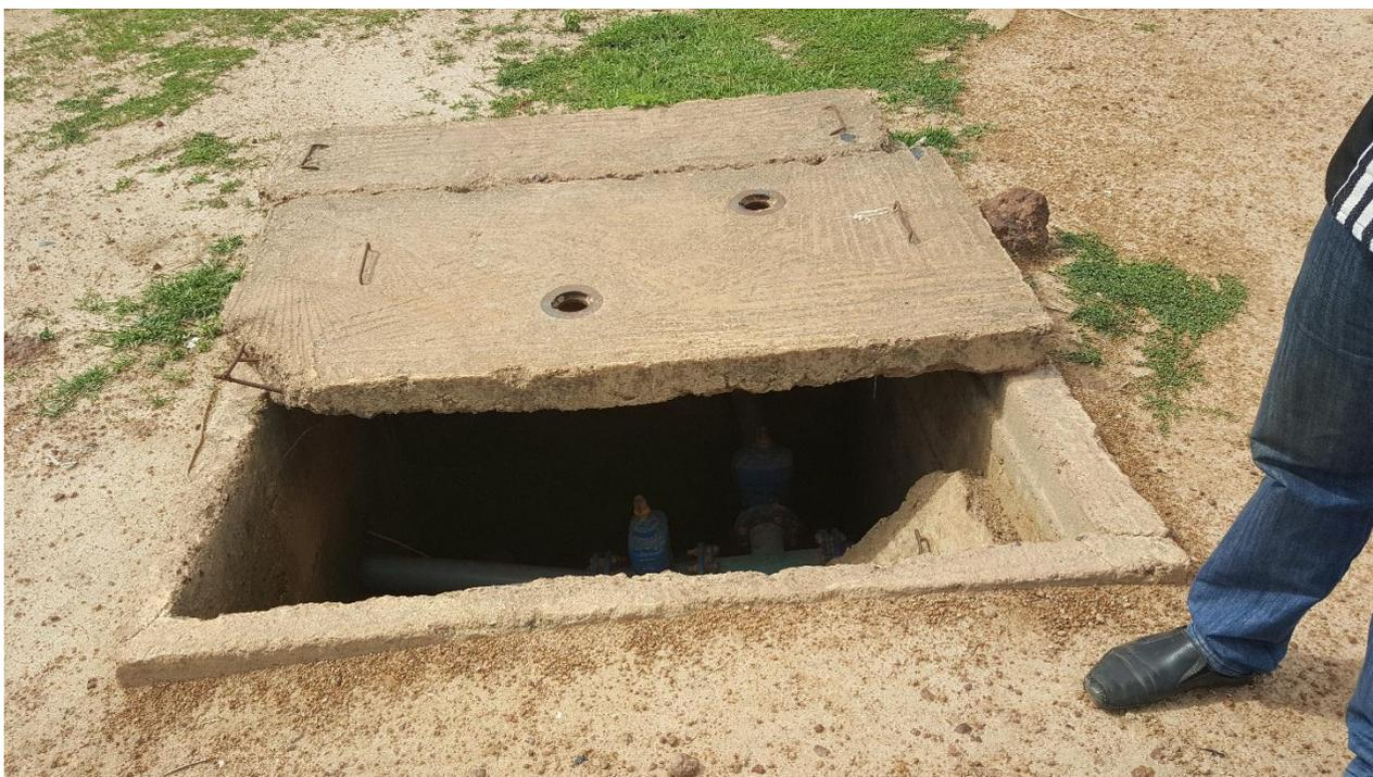
Photo n° 6 : vue regard nœud J7 « (jonction F5 et F10) du réseau de refoulement
