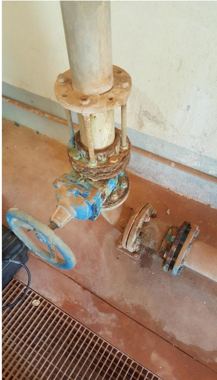
Photo n° 7 : vue d'une canalisation et accessoire salle de chloration : tuyauterie oxydée
