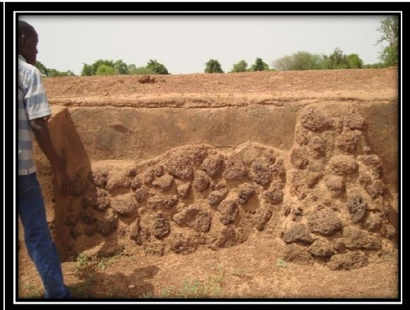
Les curasses utilisés dans le mur de soutènement à Koubri barrage
