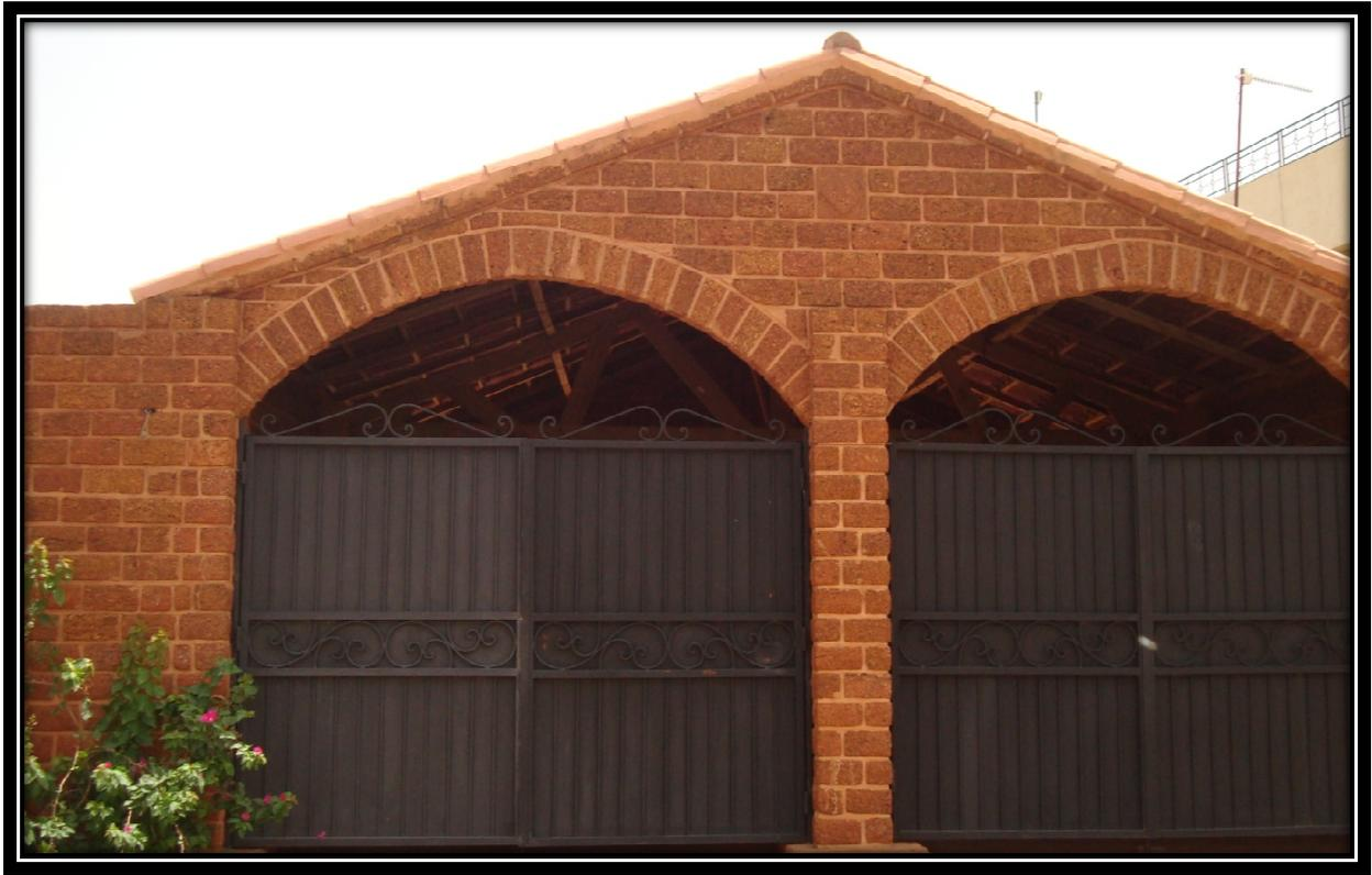
Villa construit à Ouaga 2000, la structure porteuse, le remplissage et le mur de clôture sont en BLT
