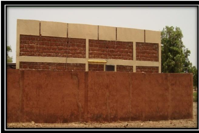
Une maison d'habitation à Koubri, les poteaux et poutres sont en béton armé et le remplissage en BLT
