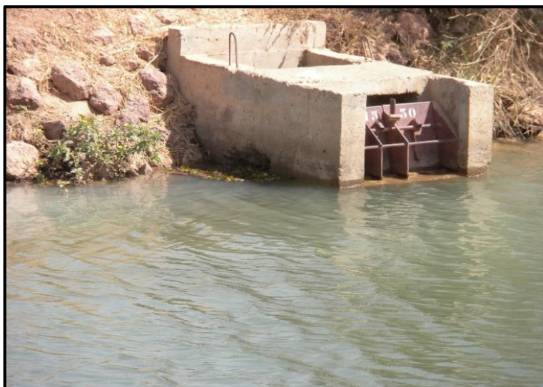
Figure 12: Module à Masque sur canal secondaire vandalisé
