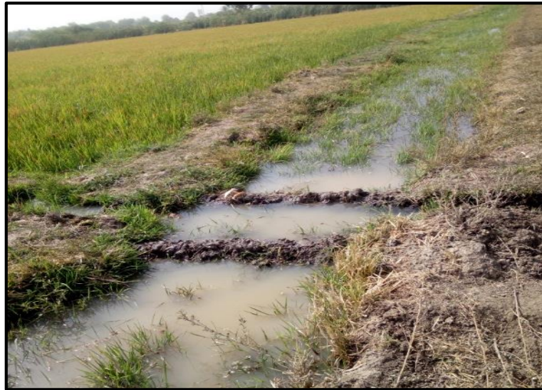
Figure 13: Drain à côté d'un canal tertiaire
