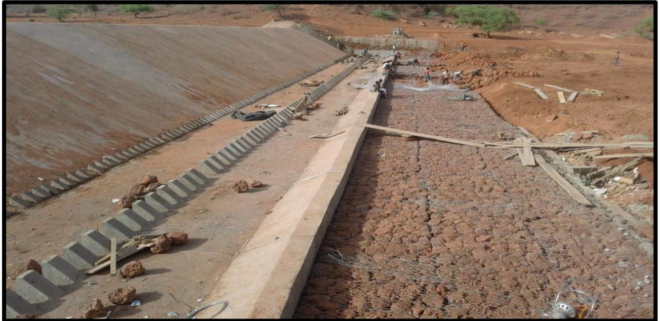
*Figure 5: Illustration du bassin de dissipation et du chenal d'évacuation*
