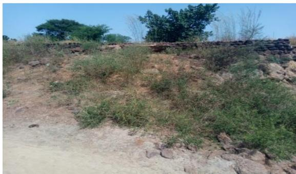
**Dégradation de la protection du talus amont de la digue par l'érosion par endroits**
