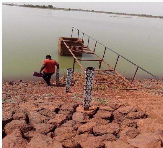
Figure 8: dégradation de la passerelle d'accès à la prise d'eau
