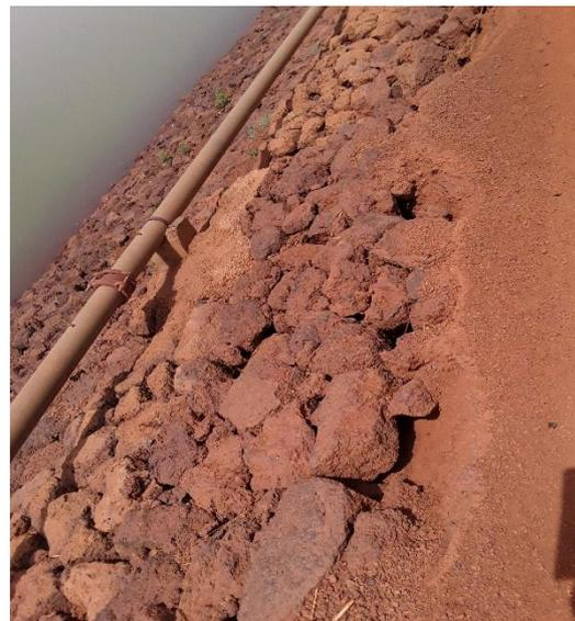
Figure 13: dégradation de la crête de digue
