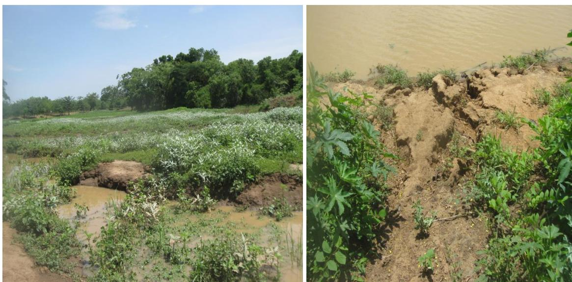
**Figure 11 :** *Cuvette comblée de dépôts solides et érosion des talus*
