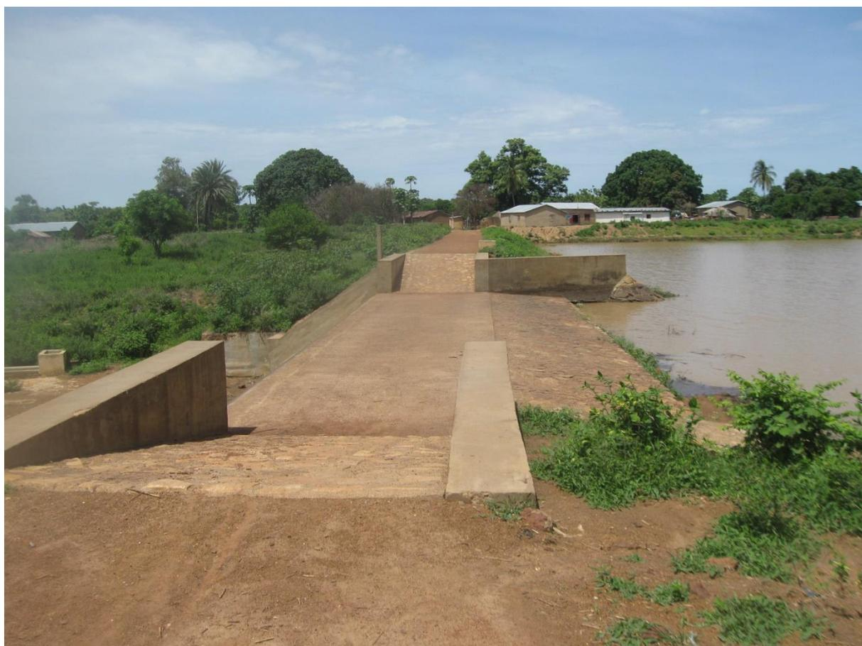
**Figure 6 :** Digue et déversoir du barrage de Bèkèt
