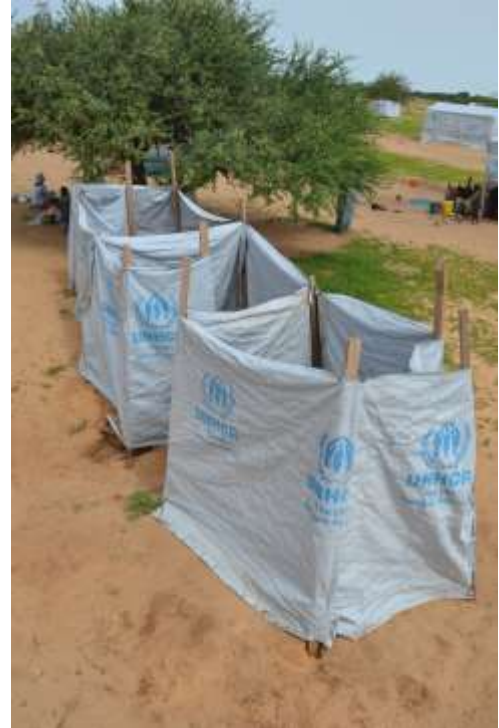
Figure 6 : Latrines communautaires d'urgence
