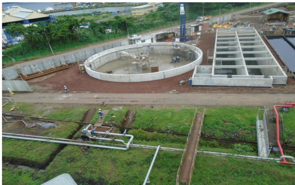
Photo2 : travaux de construction des réseaux d'eaux usées, d'eaux pluviales, de rejets d'hydrocarbures chantier SONARA-EPC
