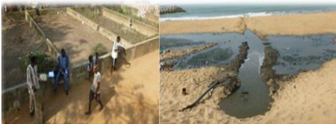
Figure 8 : Les anciens lits de séchage et les rejets des eaux non traitées sur la plage (Dadjo, avril 2017)
