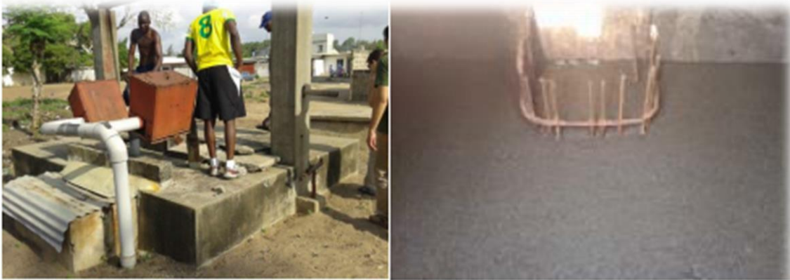
Figure 7 : Le poste de relèvement et son dégrillage à l'arrivée des effluents (Dadjo, avril 2017)
