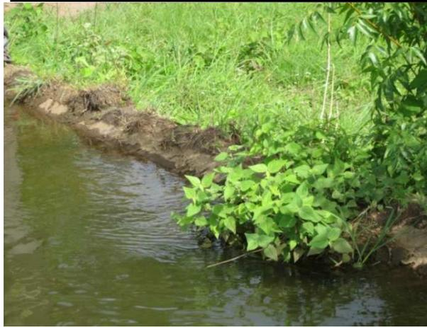
La figure 3 ci-contre montre un tronçon du canal principal sud surmonté par des mottes de terre pour en contenir les débordements. A d'autres endroits les débordements ont transporté la terre du remblai des canaux et des renforcements en béton ont été réalisés pour soutenir les dalles du béton de revêtement.
