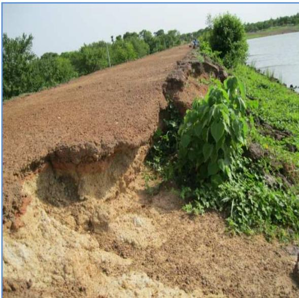
**Figure 1 : Dégradations sur la crête et le talus amont de la digue du barrage**
