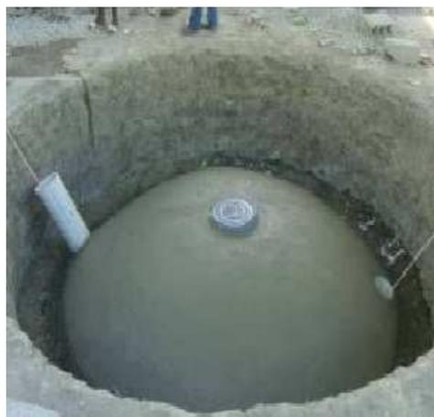
Figure 1 : un biodigesteur de 6 m3
