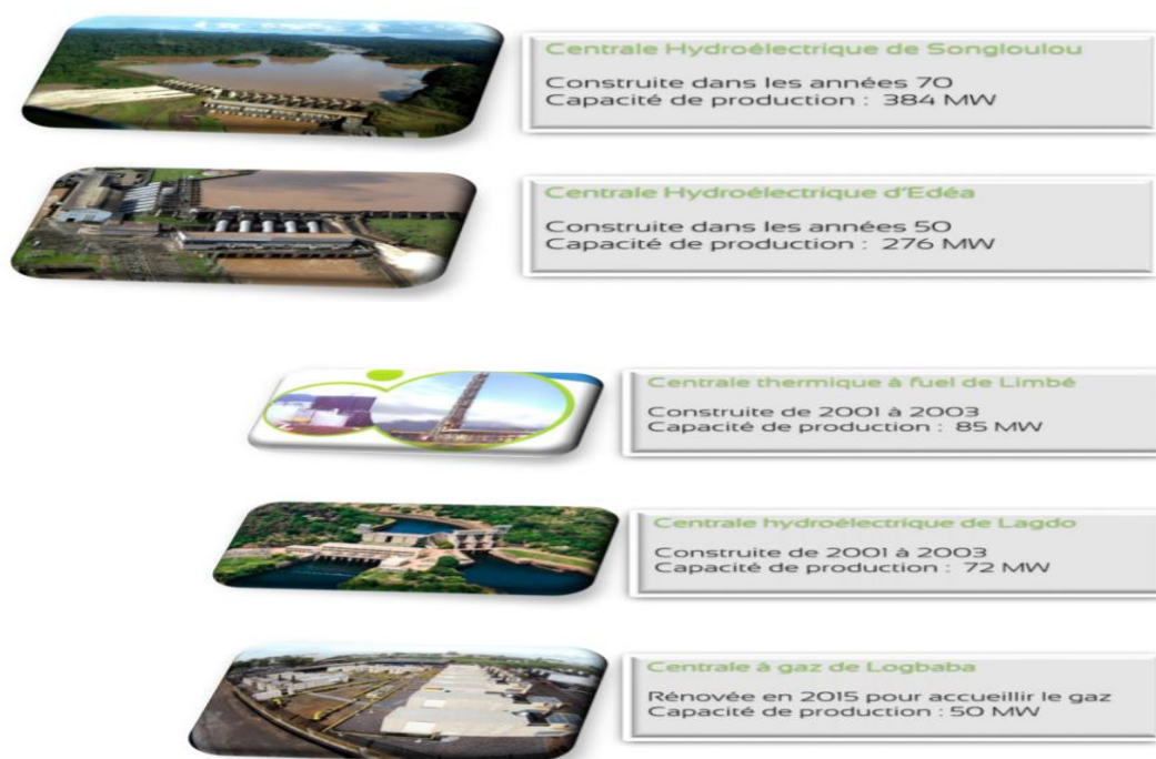
Figure 11: Les nouvelles centrales électriques au Cameroun
