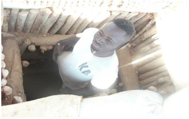
Photo N° 5 : Puits solidifié de troncs d'arbre
