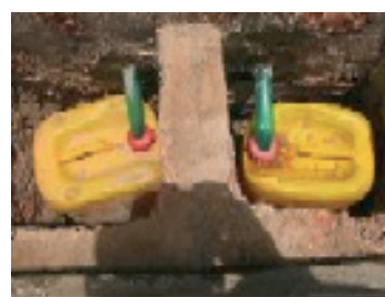
Urinoir commun dans un milieu scolaire avec récupération des urines dans des bidons de 20 litres
