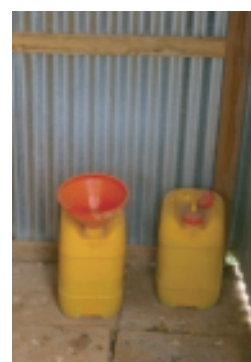
Un bloc de trois cabines avec des "bidurs" pour la récupération des urines
