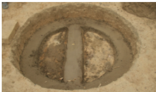
Fondation de la fosse
