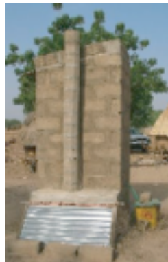
Modèle "Tecpan" simple fosse. En parpaings, vue de derrière.
