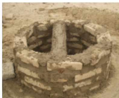
Fosse en construction
