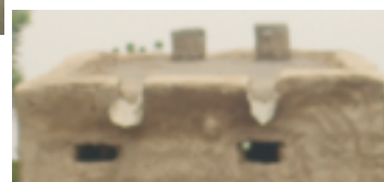
Les cheminées au dessus de la toiture en dalle
