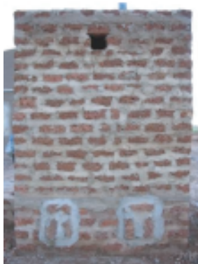
Modèle "Vietnamien" double fosse. En pierre taillée vue de derrière.
