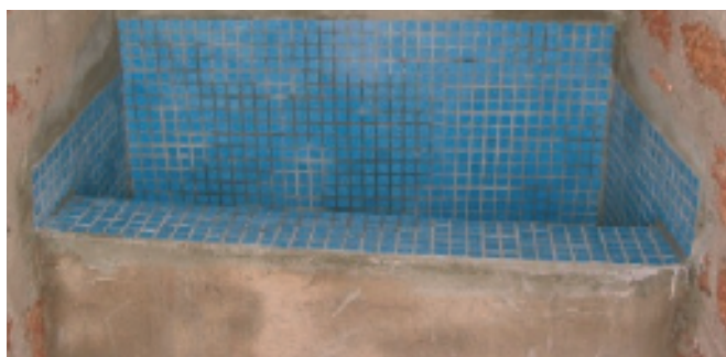
Urinoir commun dans un milieu scolaire avec récupération des urines dans des bidons de 20 litres
