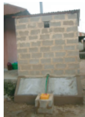
Modèle "Tecpan" double fosse. En parpaings, vue de derrière.
