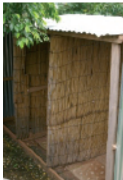
Un bloc de trois cabines avec des "bidurs" pour la récupération des urines
