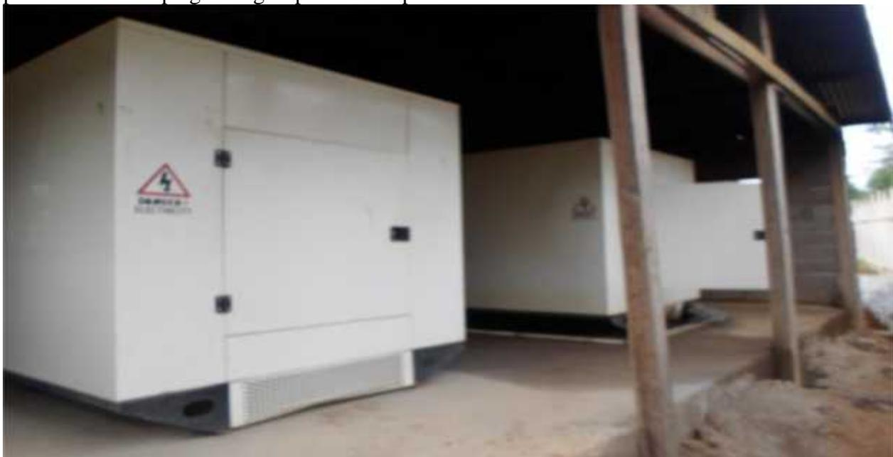
**Figure 9 : groupes électrogènes servant à l'alimentation en électricité du site**
