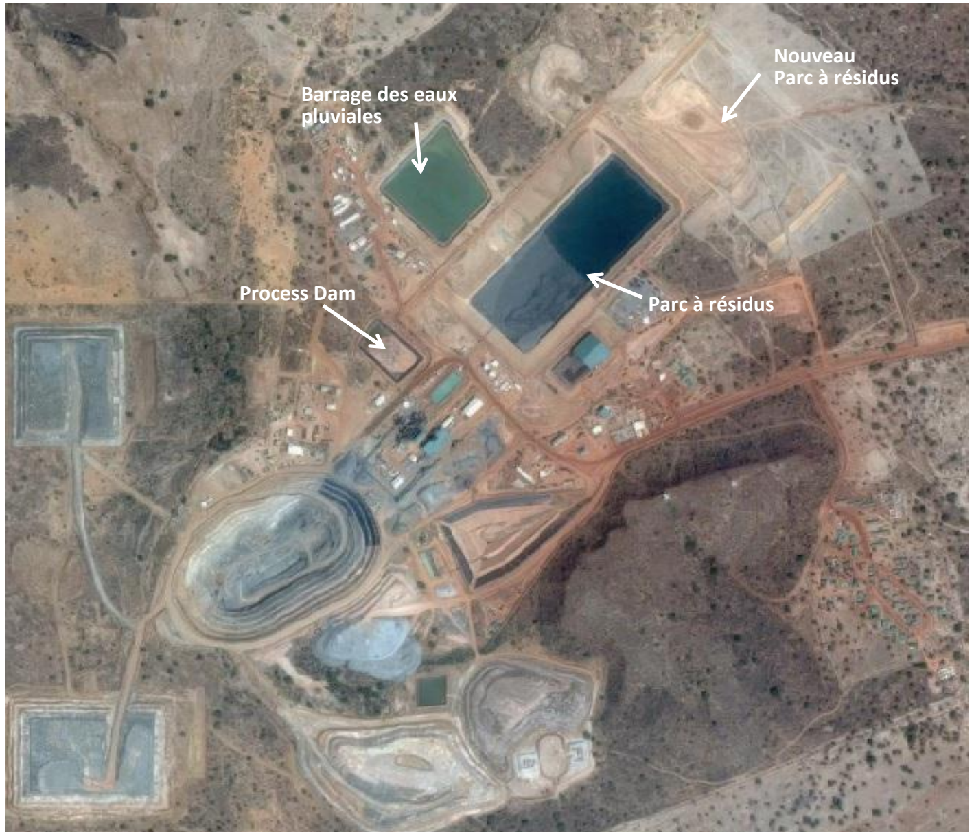
Figure 6 : Image aérienne google du parc à résidus et des infrastructures associées 2015, adaptée ZIDA Félix
