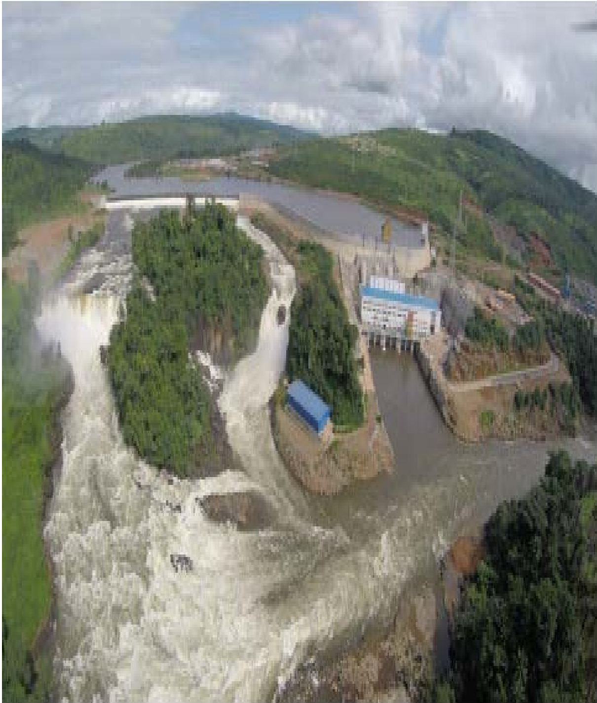
Figure 1 : Le barrage de Kaléta
