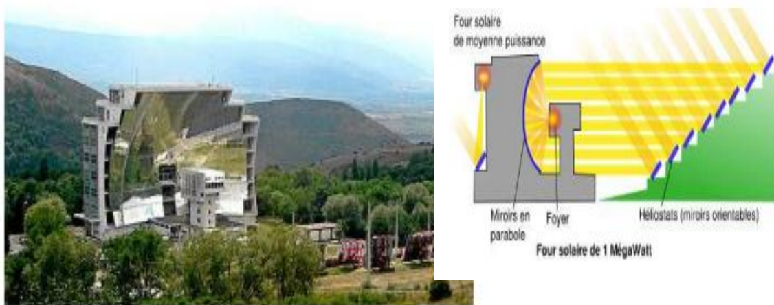
Figure 7: Four solaire d'Odeillo et principe de fonctionnement
