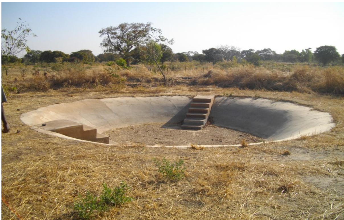
Figure 19: Esquisse d'un micro bassin réalisé par l'ONG AZN dans le Guié (Burkina Faso)
