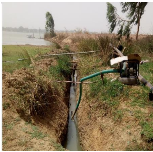
(o) :Irrigation par siphonnage
