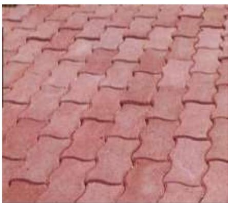
B : les pavés autobloquants en serpentine d'épaisseur 10 cm laissant des espaces d'interstices acceptables compris entre (0,5-1,5 cm). Pouvant retenir la phase solide et laissé passer le percolât.
