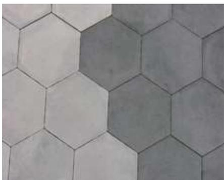
A : avec ces pavés autobloquants Hexagonal, les espaces d'interstices très restreints compris entre (0,3-0,6 cm) limiteront ainsi l'infiltration du percolât. Avec 10 cm d'épaisseur
