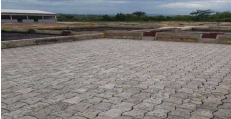
Figure 10: La pose de pavés dans les lits de séchage (Tagba, 2018)
