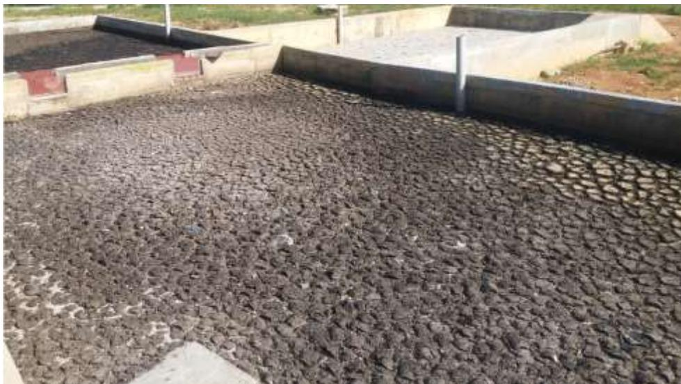
Figure 16: Boues en séchage sur un lit avec des pavés
